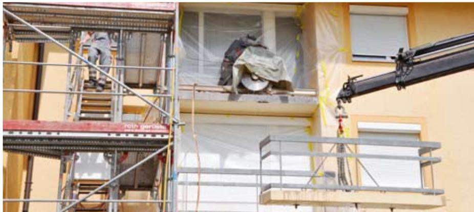
Diamont Betonbautechnik AG in Rüti ZH ein Konzept für einen möglichst schonenden Rückbau ohne Schäden an der Bausubstanz. Der Arbeitsplan sah acht Etappen vor. Pro Etappe wurden die Betonbalkone von zwei bis drei Gebäuden im Zeitraum von jeweils vier Arbeitstagen rückgebaut. Mit dem Kran-Lastwagen wurden die insgesamt 18 Elemente zur Wiederaufbereitung der Deponie zugeführt.
