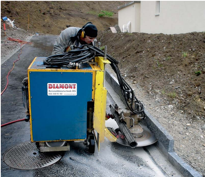
Schneiden von Granit-Stellriemen mit Spezialsäge horizontal.
