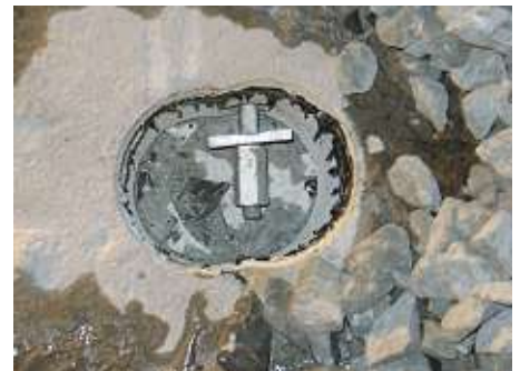
Fixierung der horizontalen Gewindestange vor dem Ausgießen.
