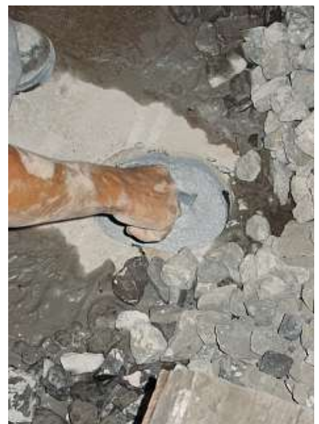
Fertig ausgegossene Horizontalverankerung.
