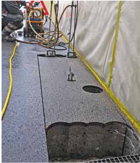
Betonpresse im Einsatz.
