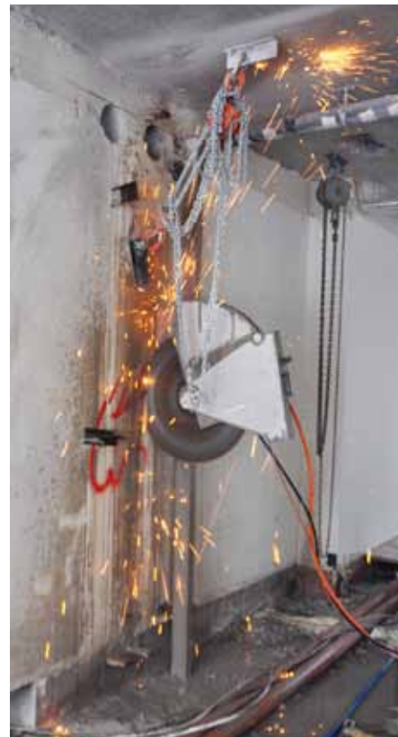
Elementweiser Abbau mittels Kreissäge und Kettenzügen.
