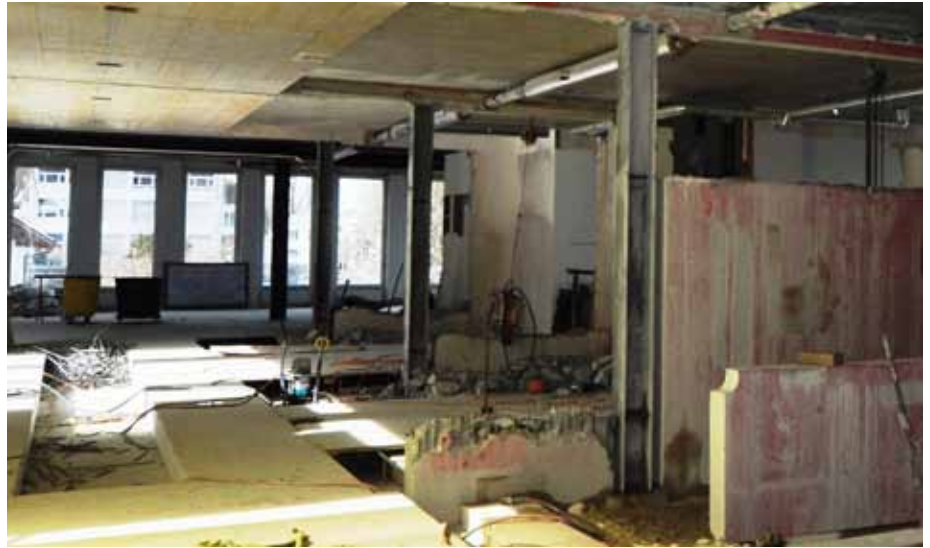
So sieht der Raum nach getaner Arbeit aus: Mehr Licht durch teilweisen Abbau der Zwischenwände.
