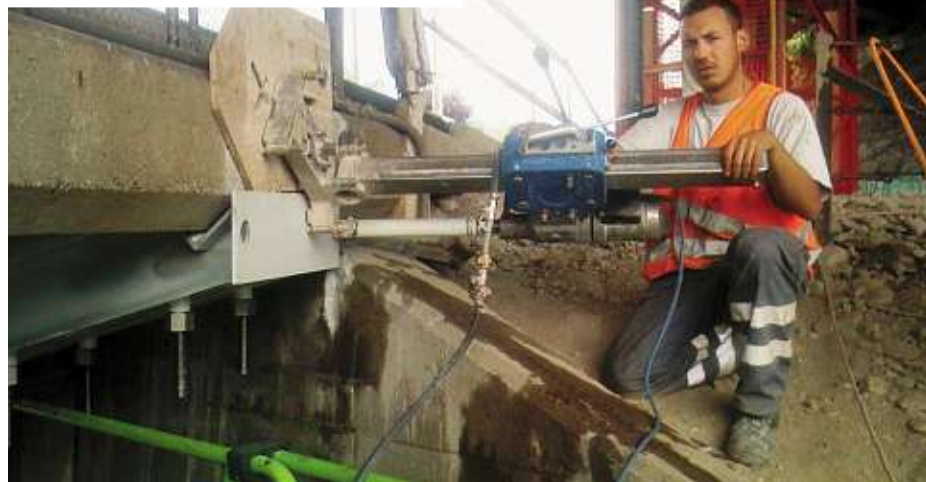
Erstellen der genauen Horizontalbohrungen.
