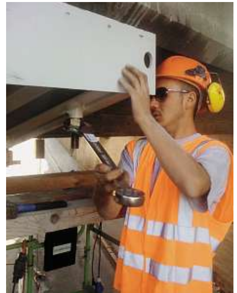
Montage der Stahlkonsole.
